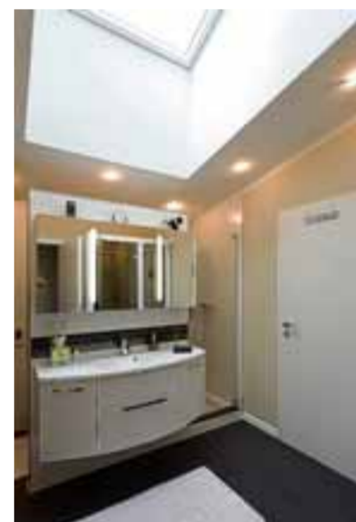
Das Bad wirkt hell und freundlich alleine durch die große Lichtkuppel. Hier sieht man besonders deutlich den hohen Dachaufbau, bedingt durch die Wärmedämmung.
